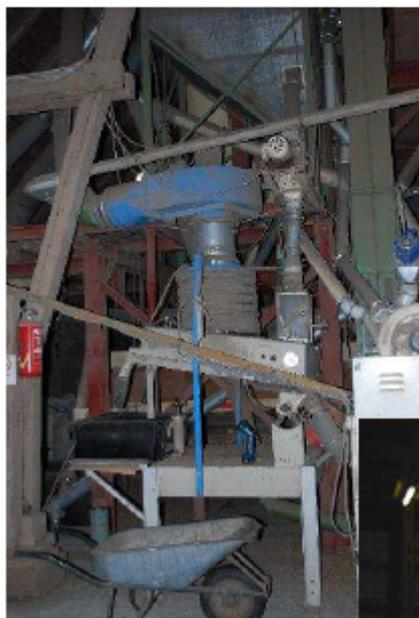
Was nun mit der vielen Spelze anfangen? Sie wird in einem ausgetüftelten Verfahren in einem Dinkelspelze-Heizwerk verarbeitet. Die gewonnene Wärme wird zum Beheizen der Gebäude, auch der weiter entfernten genutzt. So wie die Getreidebearbeitung das ganze Jahr läuft, so muss auch die Heizanlage kontinuierlich betrieben werden. Eine besondere Herausforderung ist dabei die ausgewogene Zufuhr des Heizmaterials in gleichem Maß wie die Entfernung der Asche.
