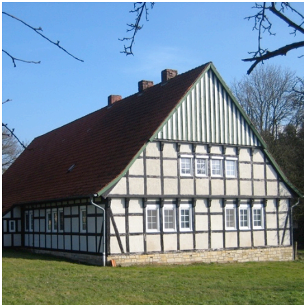
links: An der Merkelkuhle 2
