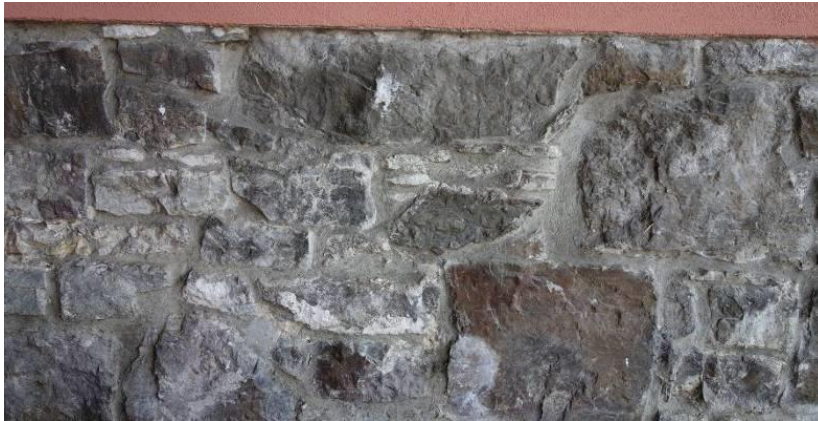
Mauerwerk aus verschiedenen Natursteinen
