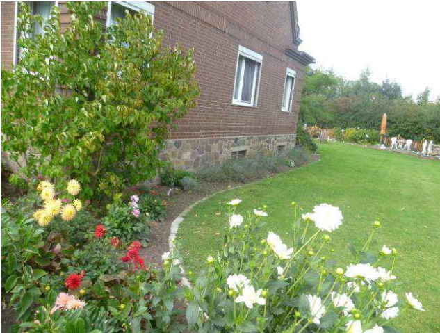
Original-Fundamente aus Findlingen, übermauert mit Tonziegeln
