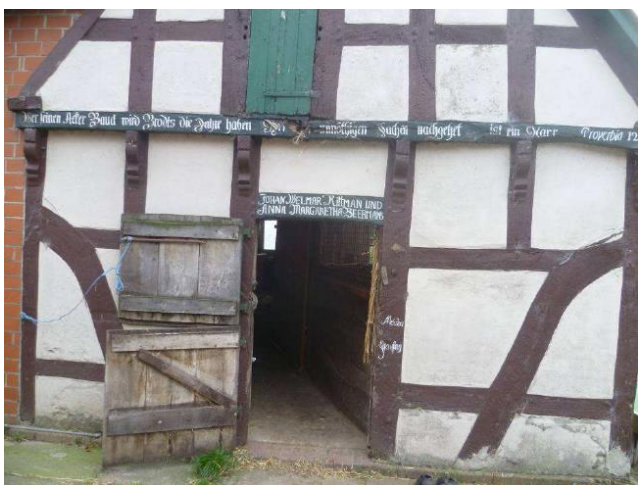
Speicher von 1771 ohne Fundamente aus Findlingsmaterial
