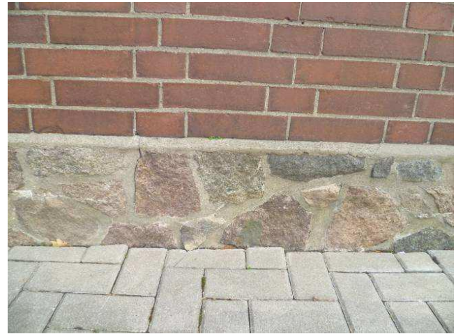
Original-Fundamente aus Findlingen, übermauert mit Tonziegeln
