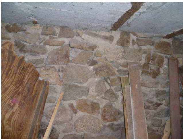
Innenmauer, heute Werkstatt
